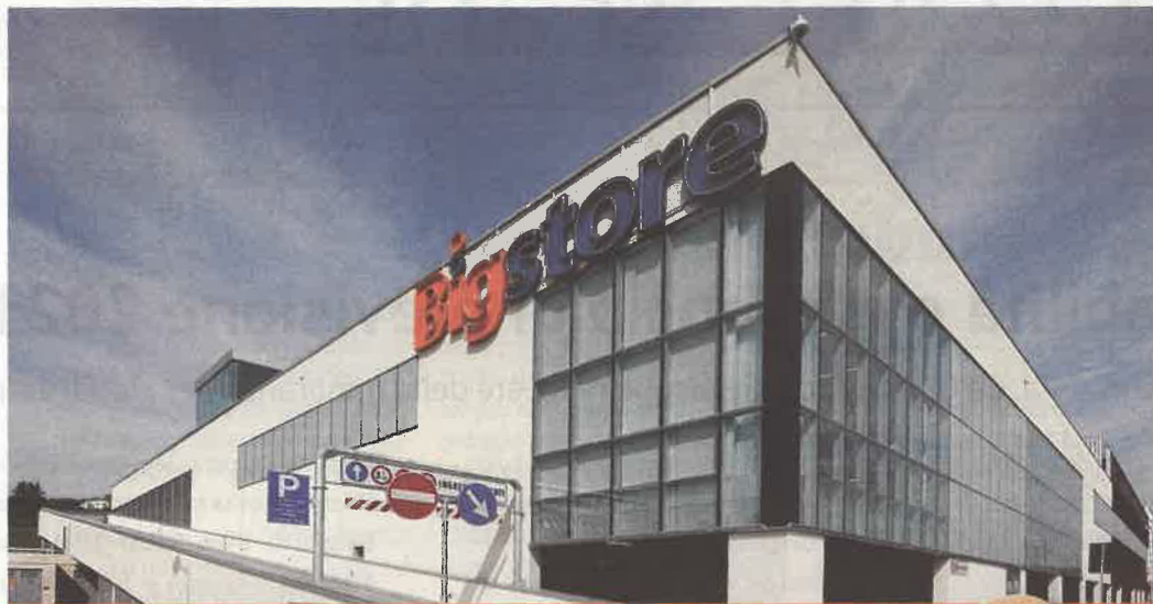
In Italia sono presenti oltre 1.300 strutture commerciali integrate
